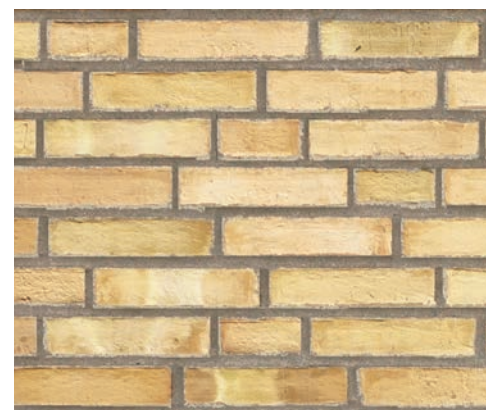
5. metselwerk donkere voeg
