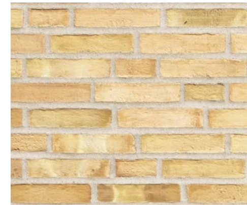
3. metselwerk lichte voeg
