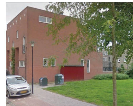
zijgevels belendende bebouwing
